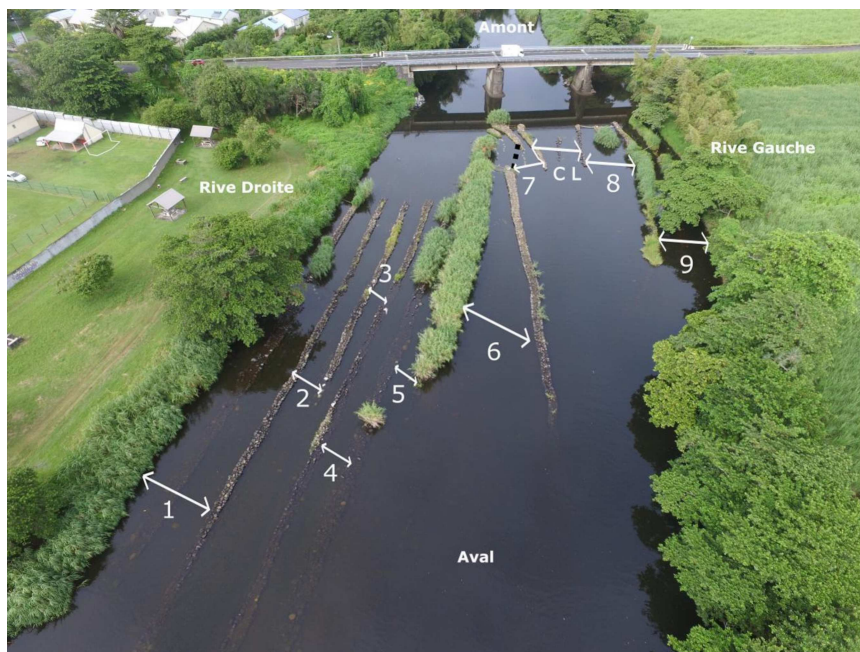
Figure 10: Vue aérienne des canaux situés en aval du Pont N2002 sur la rivière des Roches, numérotés de la rive droite vers la rive gauche (mars 2020).
